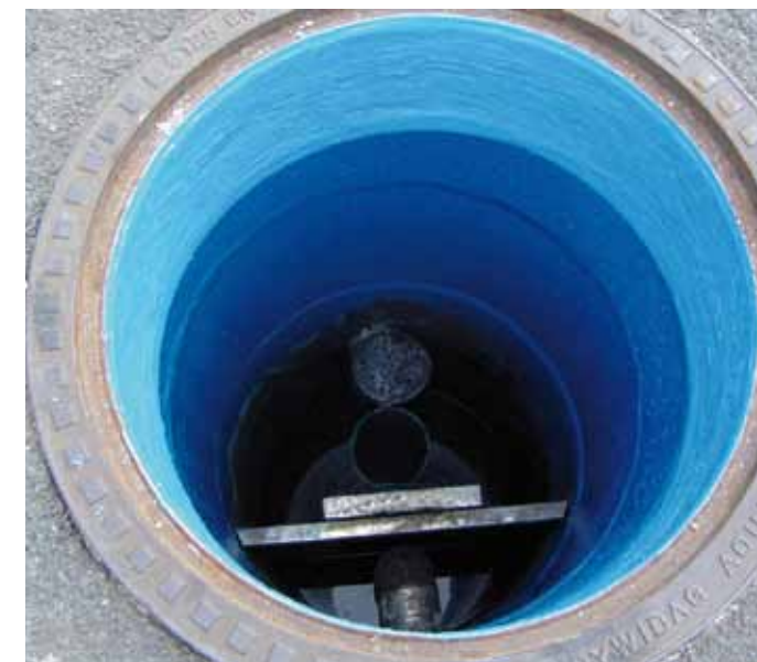
Benzinabscheider - Leichtflüssigkeitsabscheider Klasse II
