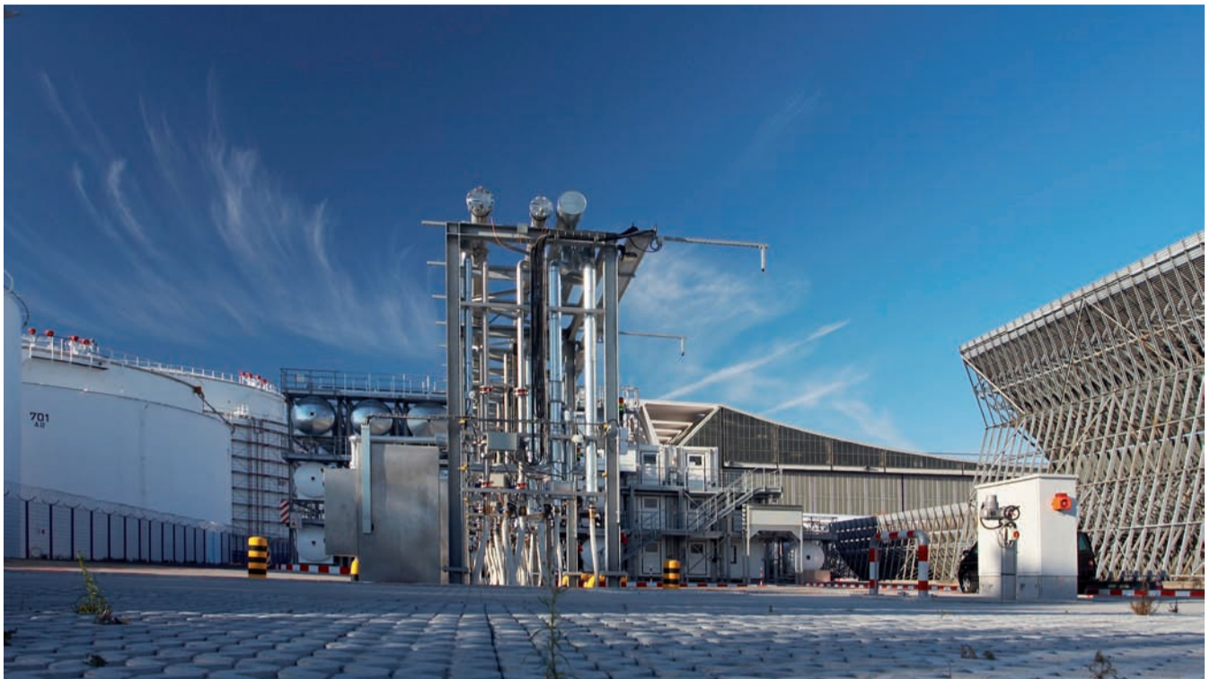
Tanklager Flughafen Frankfurt...
